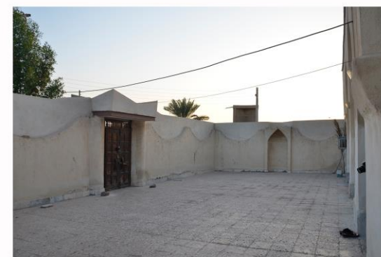
تصویر شماره ۱۰: حیاط مسجد
