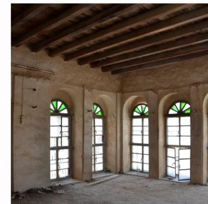
تصویر شماره ۹: فضای داخلی
