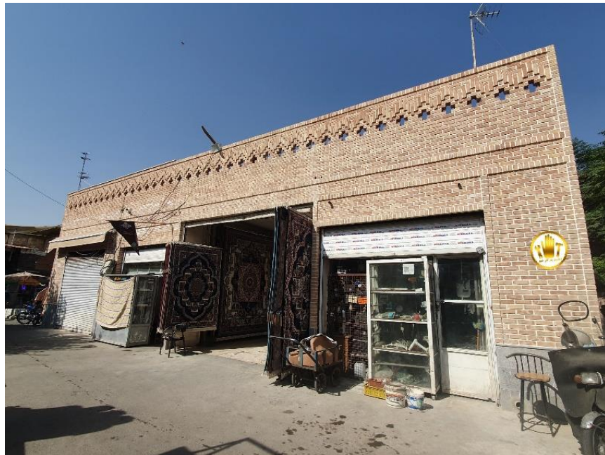
بعد از اجرا
